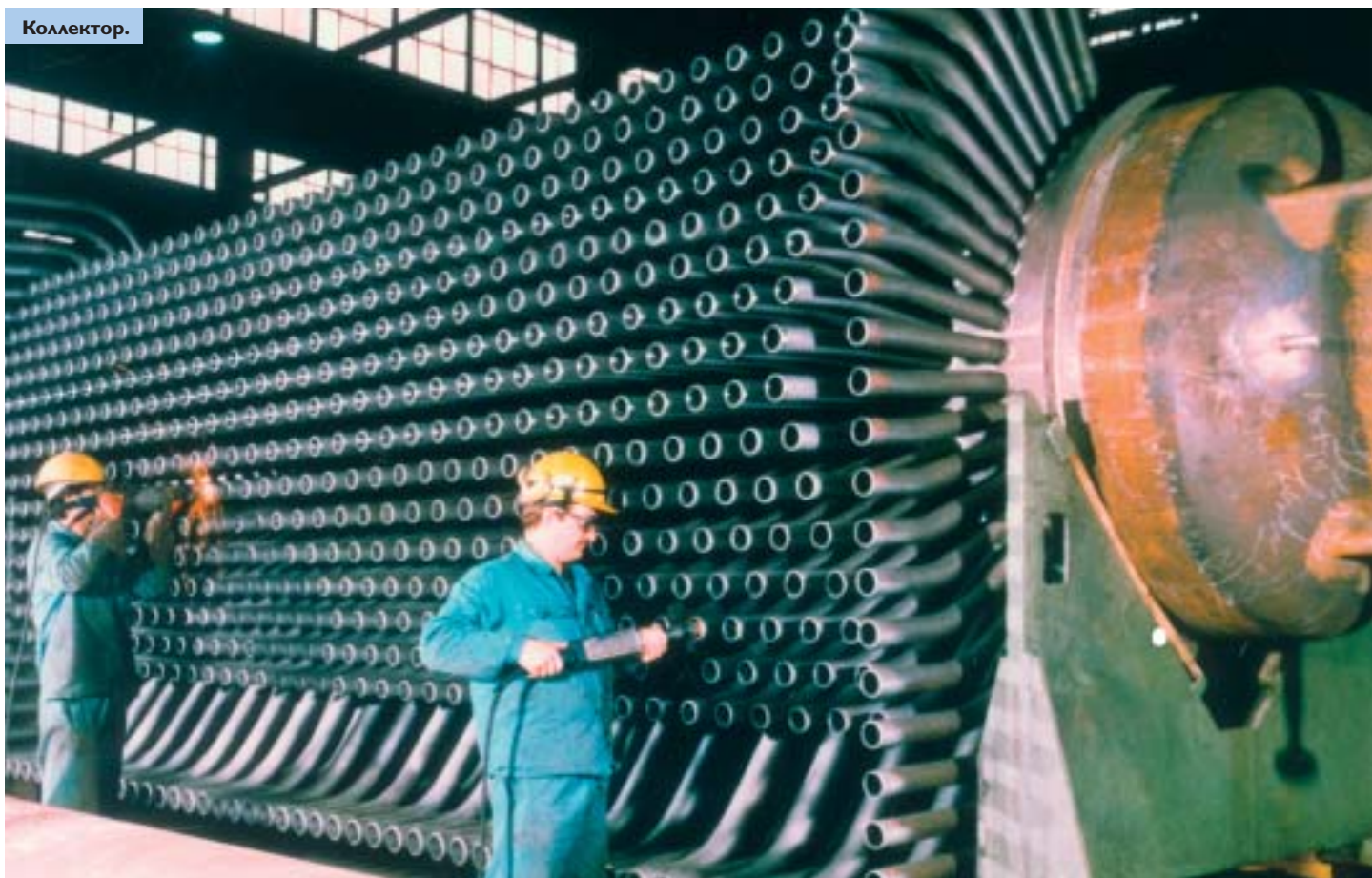
Соединительная сварка труб с коллекторами котла-утилизатора.
